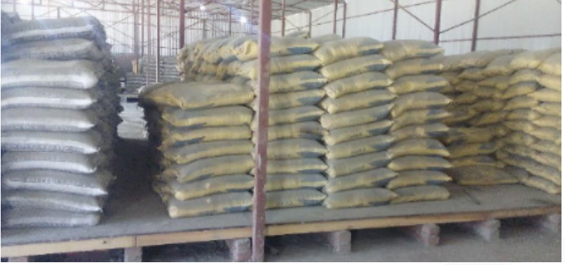
चित्र ४ : निर्माणस्थलमा सिमेन्टका बोराहरूको व्यवस्थित भण्डारण
