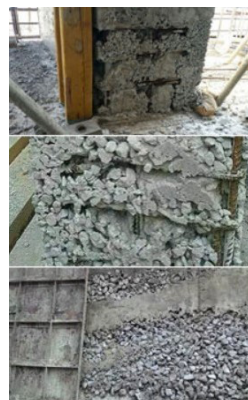
चित्र १४: बढी उचाइबाट कंक्रीट खन्याउँदा कंक्रीटबाट गिट्टी अलग भएको ।
