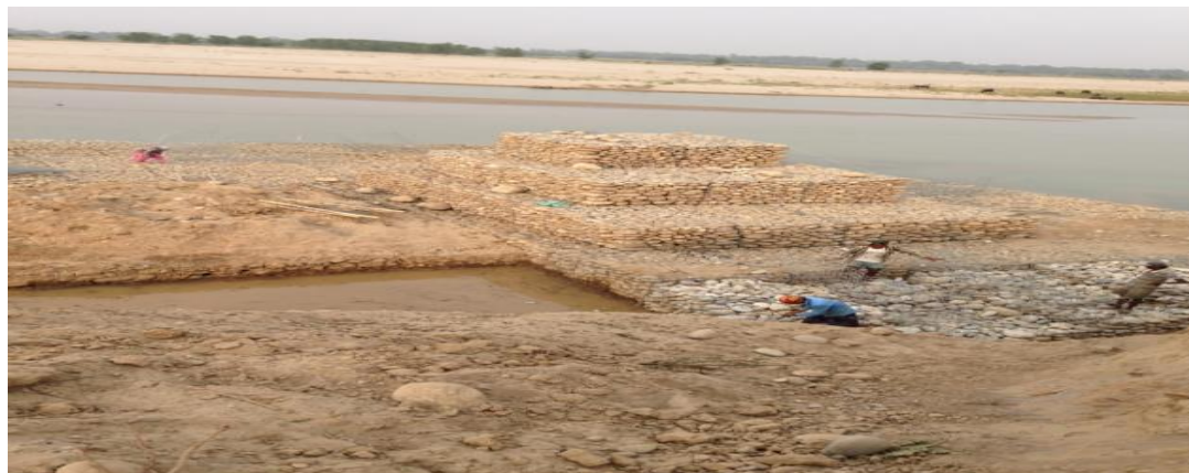
(गुलरिया नगरपालिकास्थित बबई नदी किनारमा निर्माणाधीन तटबन्ध)
