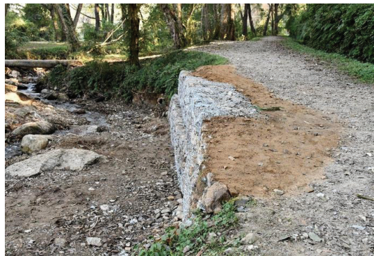
बाढीले क्षतिग्रस्त बाटोलाई Gabion Wall लगाइएको
