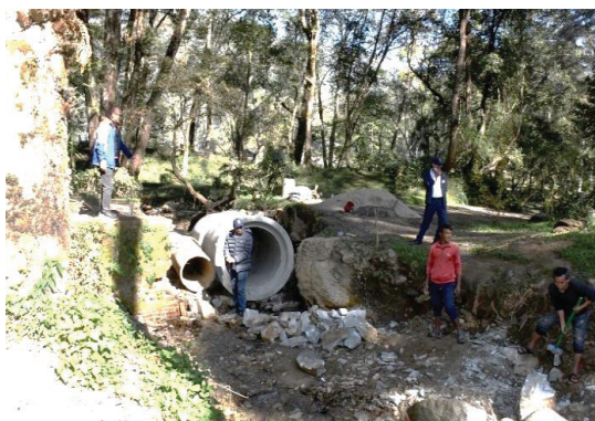
उद्यानमा २०८१ असोजको बाढीले क्षतिग्रस्त पुल पुनः निर्माण
