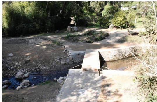
उद्यानमा २०८१ असोजको बाढीले क्षतिग्रस्त पुल पुनः निर्माण
