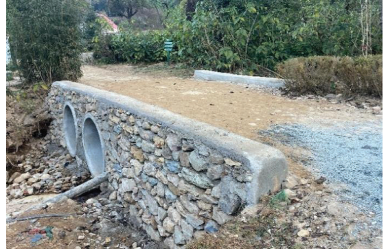
२०८१ असोज बाढी पछि Rock Garden नजिक नयाँ पूल निर्माण
