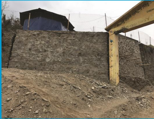
रिटेनिड वाल निर्माण
