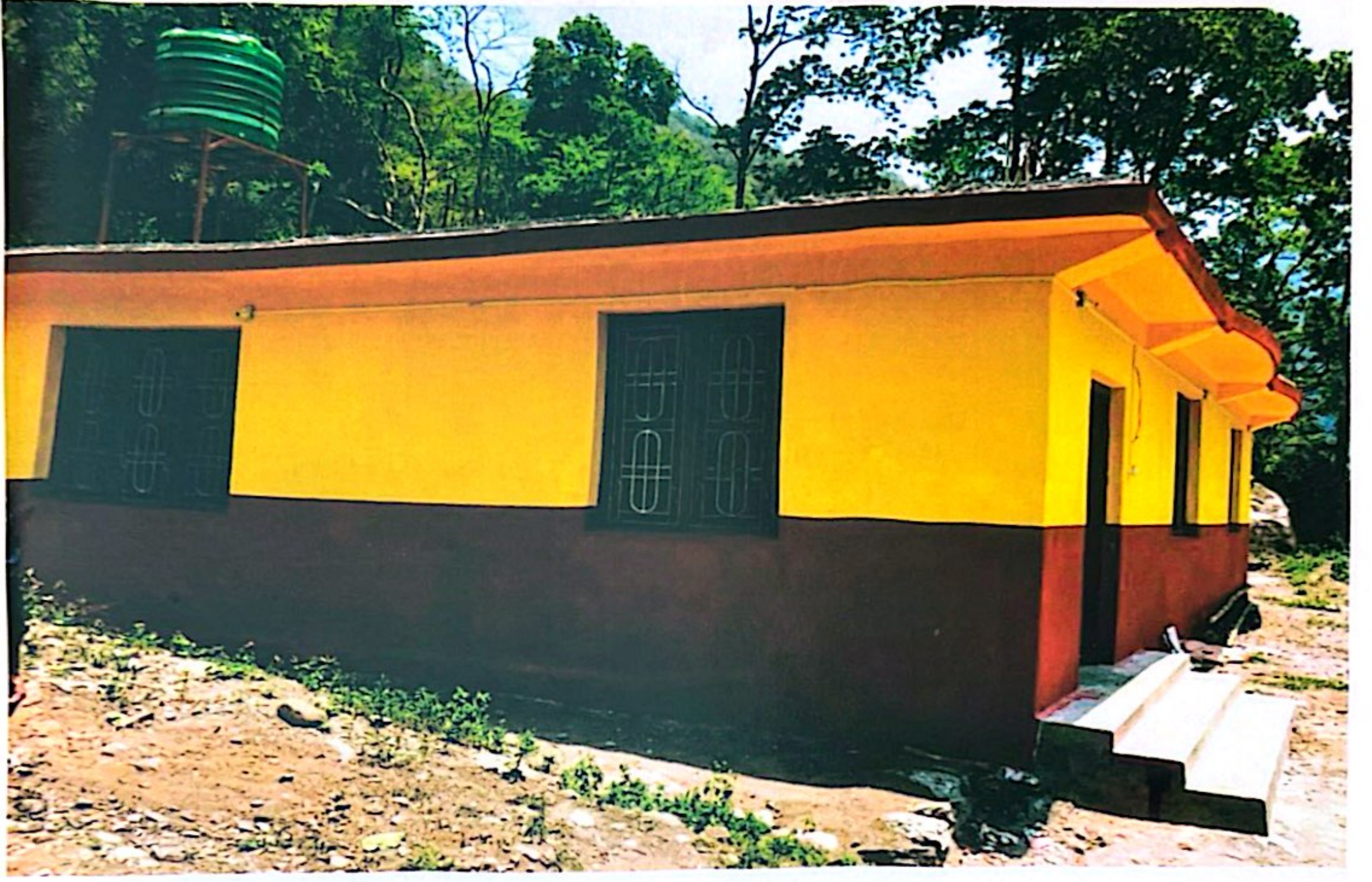
संखुवादोभान पोष्ट भवन निर्माण
