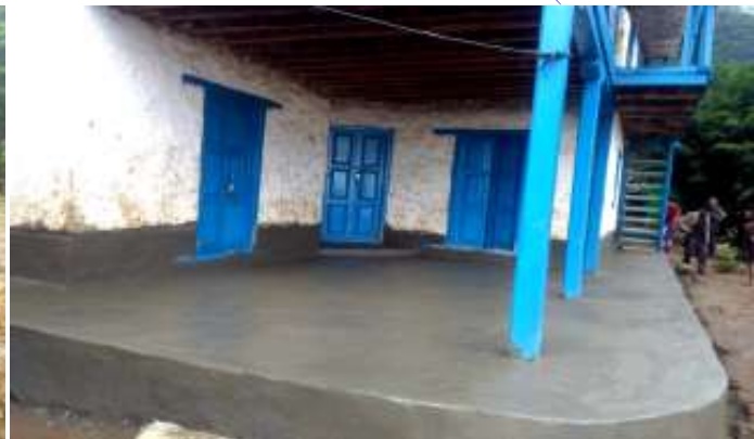
याङ्सीमा पोष्ट भवन मर्मत, संखुवासभा
