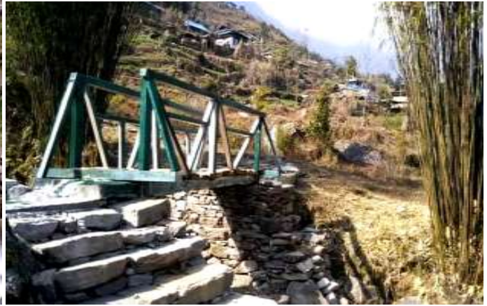
पूल निर्माण,टासीगाउ, टासीखोला
