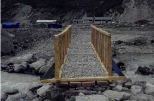
काठे पूल निर्माण, मकालु बेस क्याम्प
