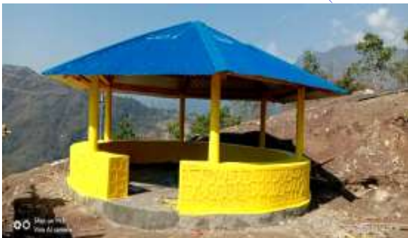
गोलघर निर्माण, हेदाङ्ना गढी, संखुवासभा
