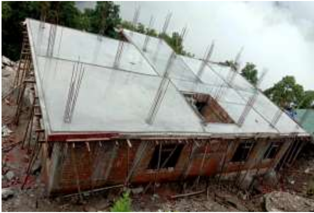
सेक्टर कार्यालय भवन निर्माण, हेदाङ्ना गढी
