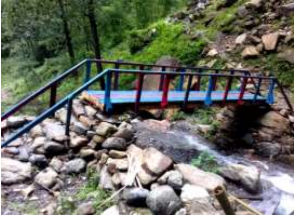
पूल निर्माण, काली खोला, ताम्कू सेक्टर
