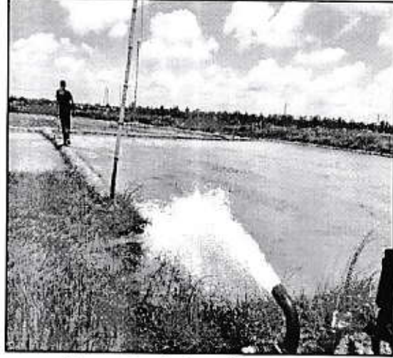
स्यालो ट्यूबवेल निर्माण ,गौरिगंज ४, झापा
