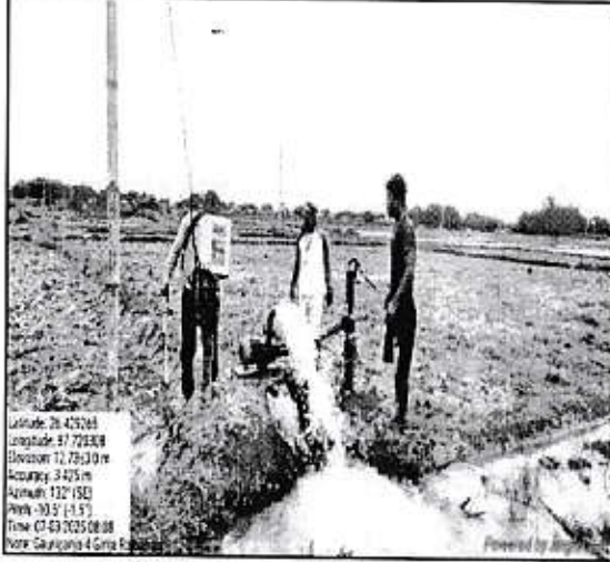
स्यालो ट्यूबवेल निर्माण ,गौरिगंज ४, झापा
