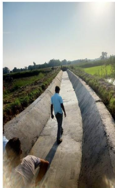
साखा नहरको ईन्टेक तल लाईनिङ कार्य
