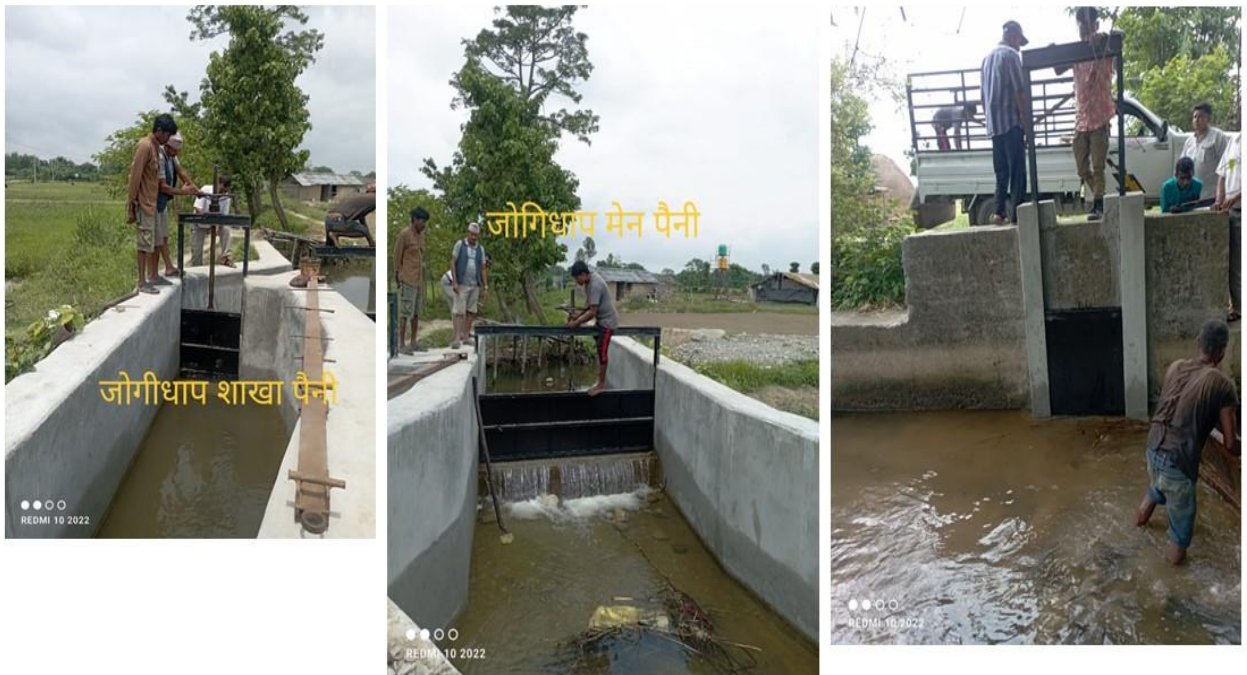
मुसहरघट्टा सिंचाई प्रणाली मा गेट जडान
