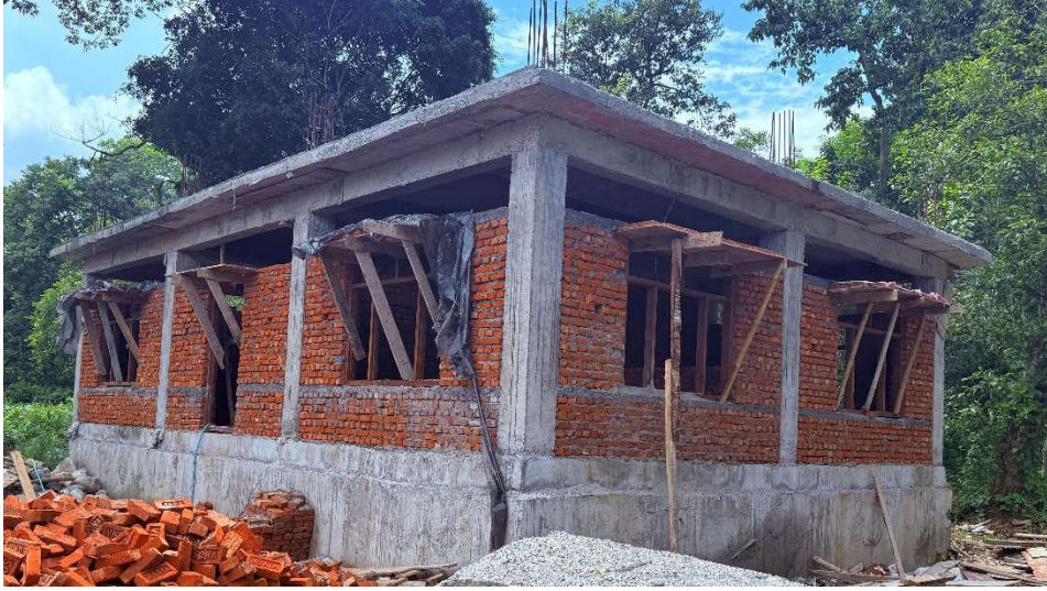
पोष्ट भवन निर्माण
