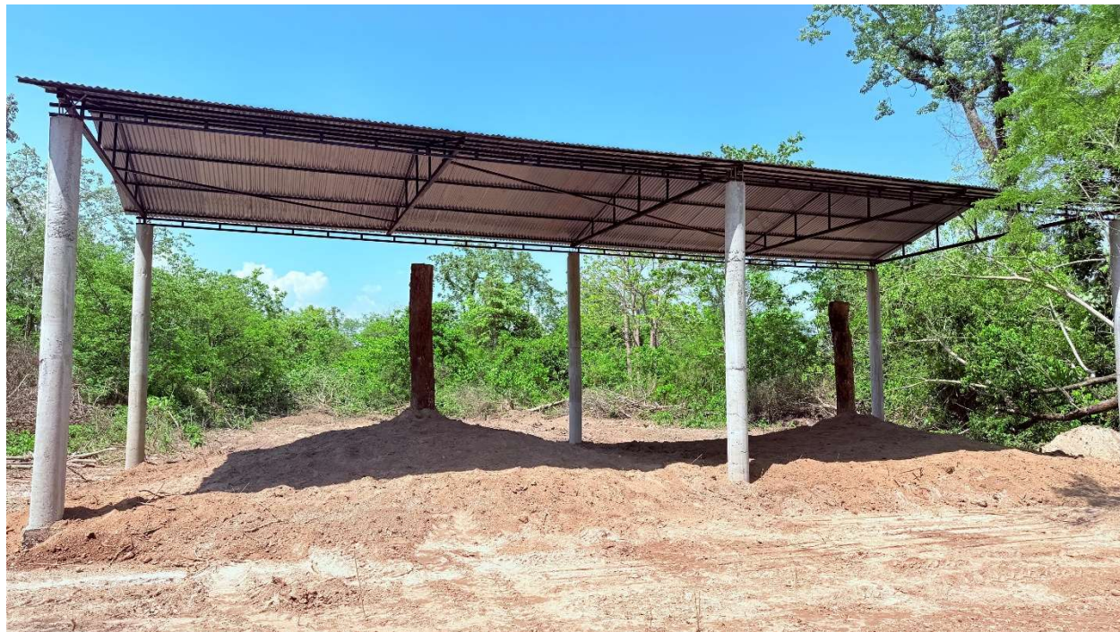
हात्तीको सेडघर निर्माण, बाँदरझुला
