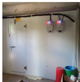
कोल्ड रुम निर्माण
