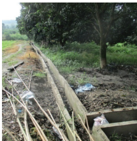
सिंचाई कुलो निर्माण
