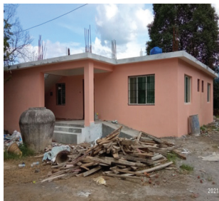
कार्यालय भवन निर्माण
