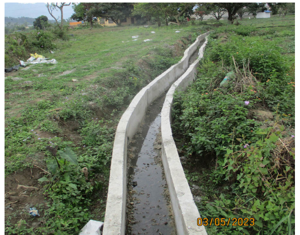
सिंचाईको लागि कुलो मर्मत तथा निर्माण
