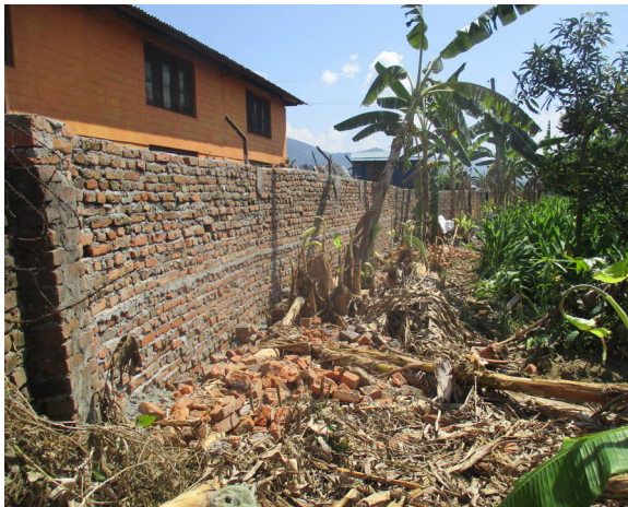
क्षतिग्रस्त पर्खाल मर्मत
