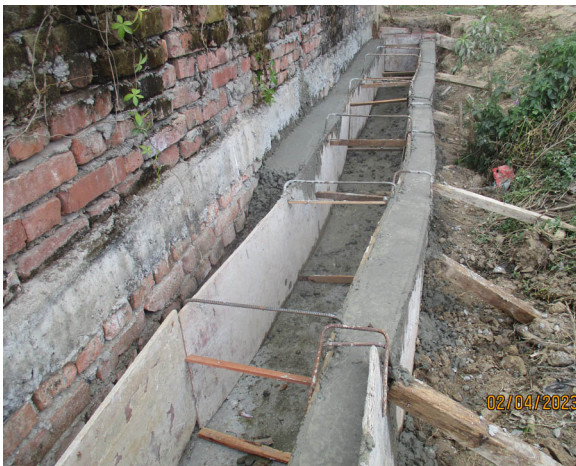
सिंचाईको लागि कुलो मर्मत तथा निर्माण
