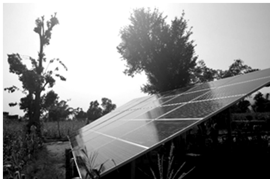
चित्र ७.२: कृषि उद्योगलाई बढावा दिन जमिनमुनिको पानी निकाल्न चाहिने ऊर्जा प्राप्त गर्नका लागि जडान गरिएका सोलार प्यानलहरू
