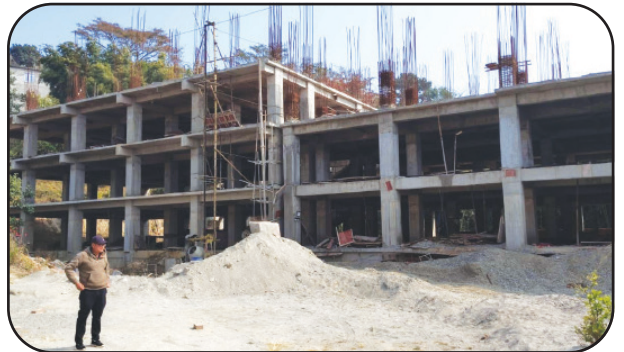
निर्माणाधीन धनकुटा अस्पतालको भवन
