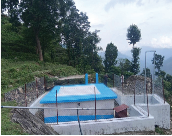
छामघाट खोला झुप्रेसाल भैसेखोर मन्दिर लिफ्ट खानेपानी योजना नारायण न.पा.-९, दैलेखको आरसीसी ट्यांकी
