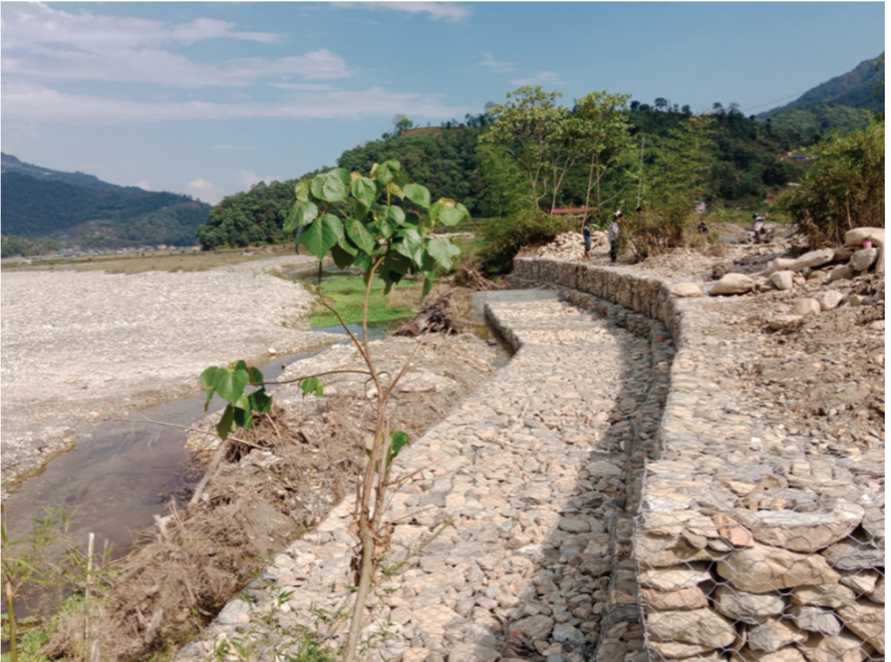
बाम्दी खोला किनारा संरक्षण, पोखरा-२३, कास्की
