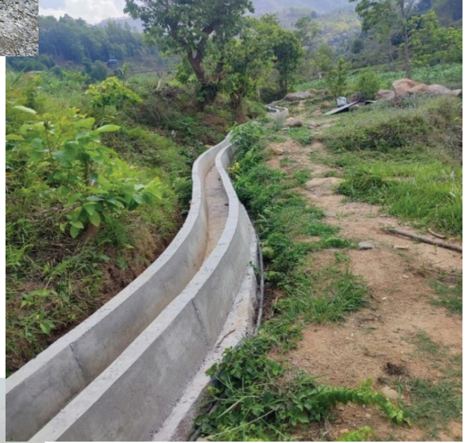
साना सिंचाई कुलो संरक्षण निर्माण, ← पालुङ्टार-१०, गोर्खा
