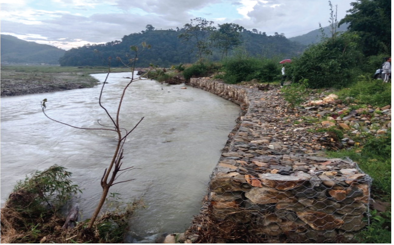
तोरा खोला किनारा संरक्षण, पोखरा-२३, कास्की
