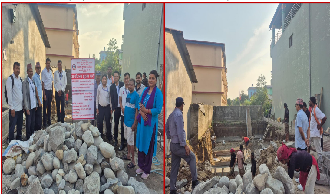
निर्माणाधीन हुलाक कार्यालय, देवचुली नगरपालिका को भवन (नवलपरासी पूर्व) स्थलगत अनुगमन कार्य पश्चात्
