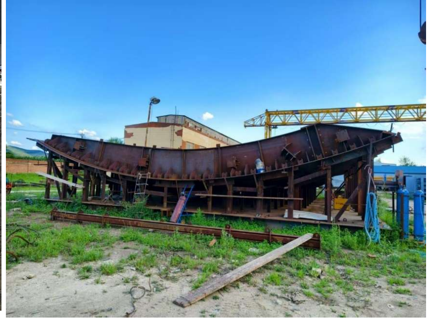
फोटोहर १०: विद्युतगृहका लागी Installation Grounding Works (वांया) र वांघस्थलका लागी Radial Gate (दांया)
