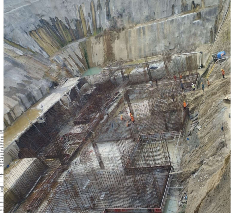
फोटो ६ : विद्युतगृह (Powerhouse) रूपरेखा तथा निर्माण कार्य
