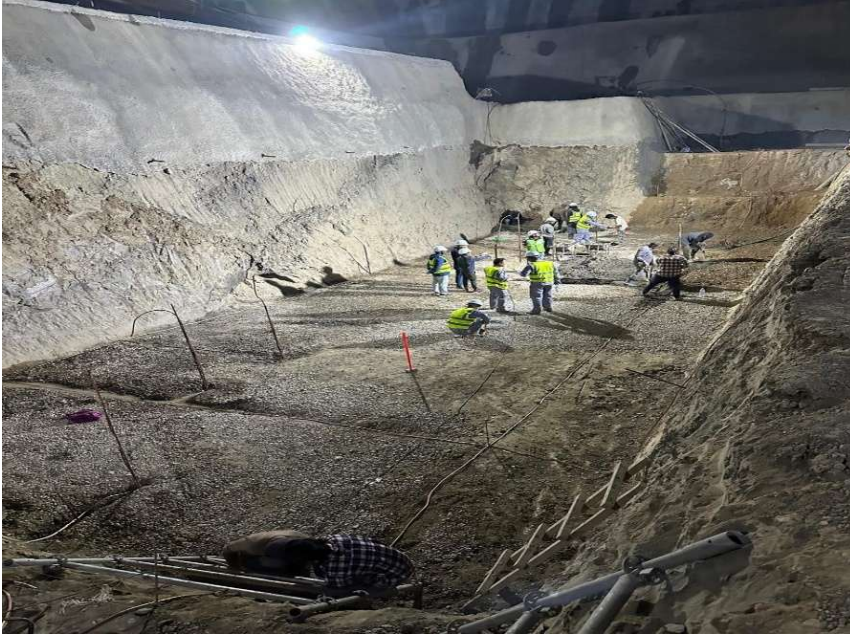
फोटोहर १०: विद्युतगृहका लागी Installation Grounding Works (वांया) र वांघस्थलका लागी Radial Gate (दांया)
