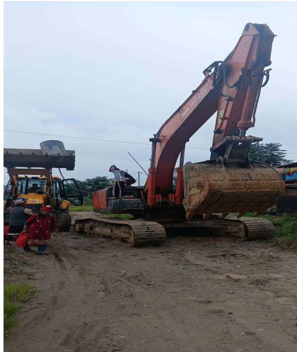
झ्याङ्ली सडक मर्मत कार्य
