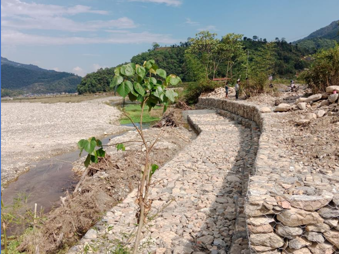
बाम्दी खोला किनारा संरक्षण, फेवा संरक्षण कार्यक्रम, पोखरा-२३, कास्की
