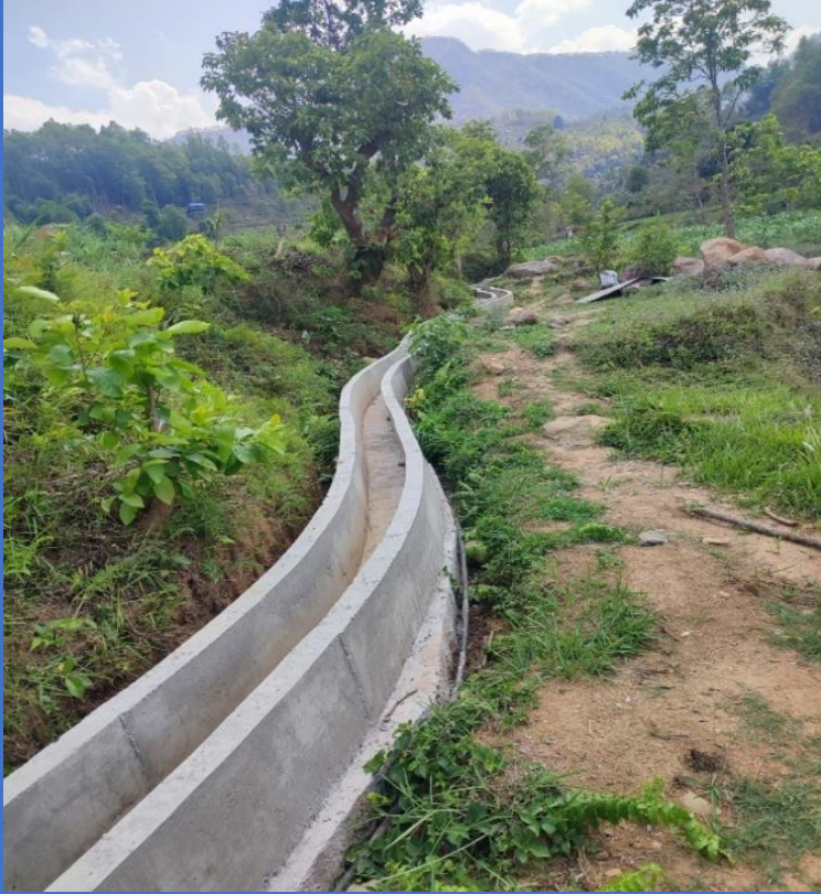
साना सिंचाई कुलो संरक्षण/निर्माण पालुङ्गटार-१०, गोर्खा
