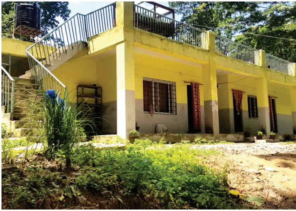
जीर्ण अवस्थामा रहेको भवनको माथिल्लो तल्ला हटाई तल्लो तल्ला मर्मत सुधार (पानीमुहान)
