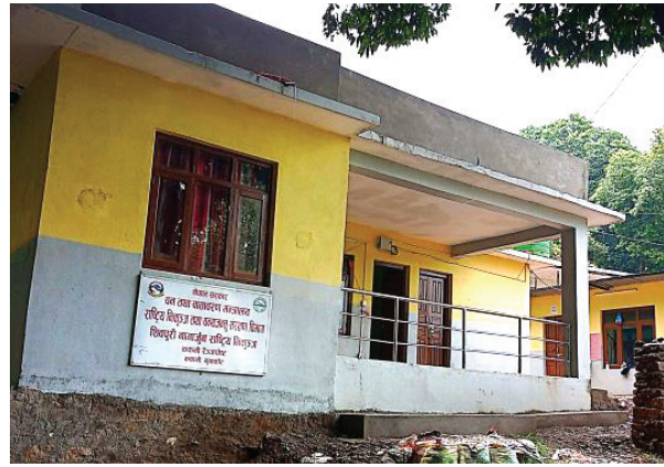
पोष्ट भवन मर्मत (ककनी)
