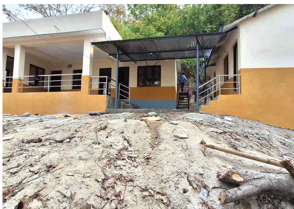
पोष्ट भवन निर्माण (नयाँपाटी)
