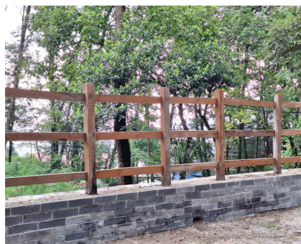
कम्पाउण्ड वाल निर्माण (पानीमुहान)
