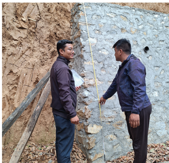
रिटेनिड वाल निर्माण-नागार्जुन
