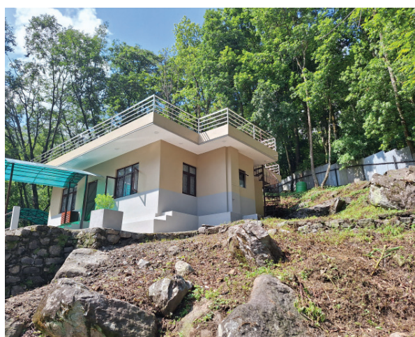
भवन मर्मत (पानीमुहान)
