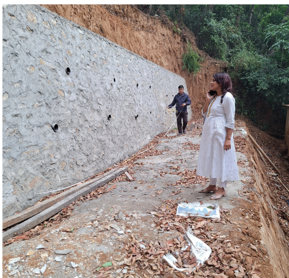
रिटेनिड वाल निर्माण-नागार्जुन
