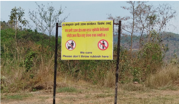
साईनबोर्ड/सूचना बोर्ड निर्माण
