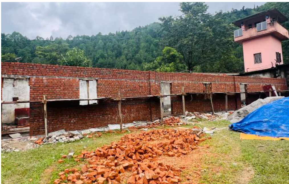
निर्माणाधीन सशस्त्र प्रहरी बलको ब्यारेक ।
