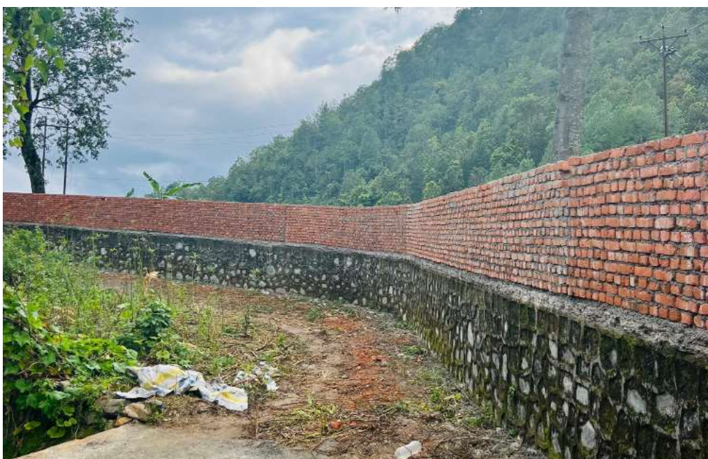
निर्माणाधीन बाहिरी पर्खाल ।
