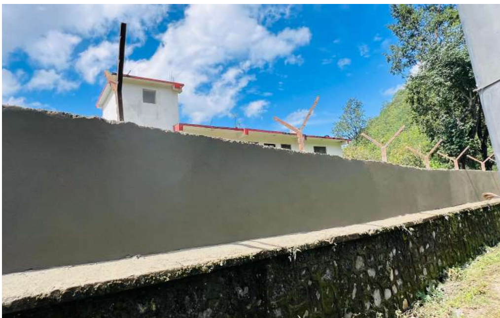
निर्माणाधीन बाहिरी पर्खाल ।
