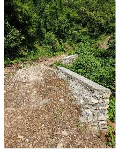
रिटेनिड वाल निर्माण
