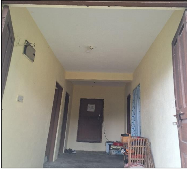
पोष्ट भवन मर्मत (जगात)
