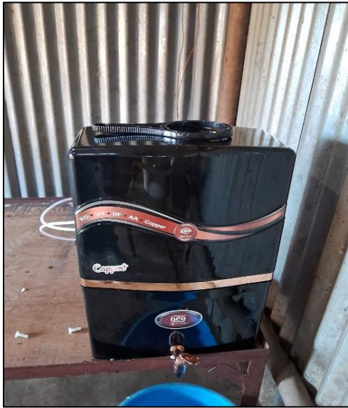
खानेपानी निर्माण/पाईप जडान कार्य (झुले पोष्ट)
