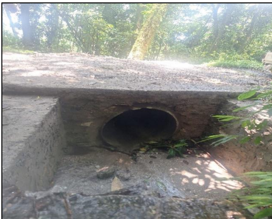
कल्भर्ट निर्माण (पानी मुहान)
