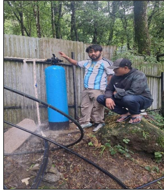
खानेपानी निर्माण/पाईप जडान कार्य (पानीमुहान)
