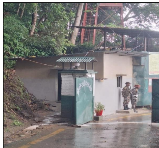
पोष्ट भवन मर्मत (नागार्जुन)
