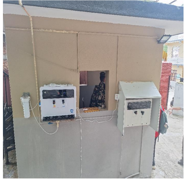
खानेपानी निर्माण/पाईप जडान कार्य (पानीमुहान)
