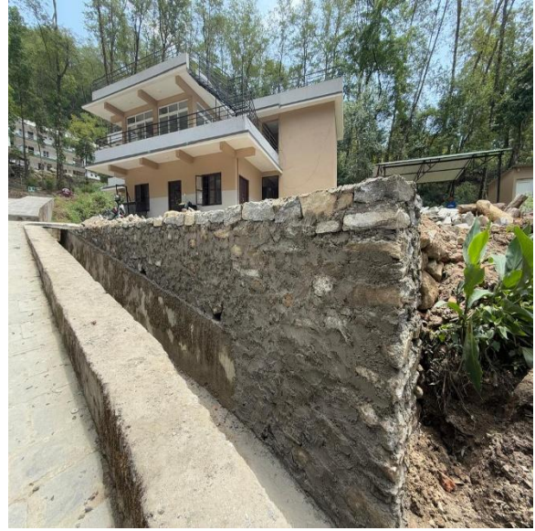
सूचना केन्द्र भवन मर्मत(पानीमुहान)
