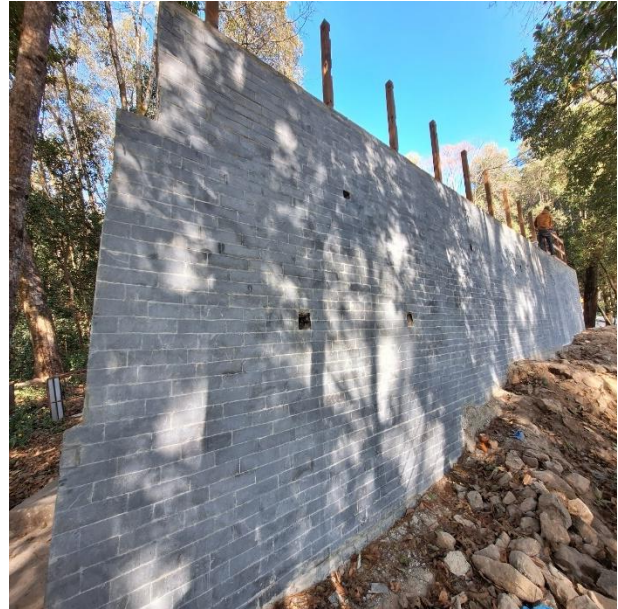
कम्पाउण्ड वाल निर्माण (पानीमुहान)
