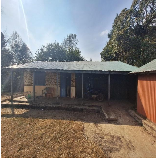
पोष्ट भवन मर्मत(मणिचुड)
