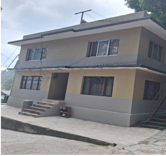
भवन मर्मत (पानीमुहान)
