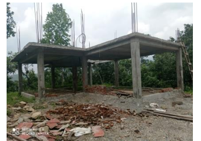
अपुरो कर्मचारी आवास भवन
