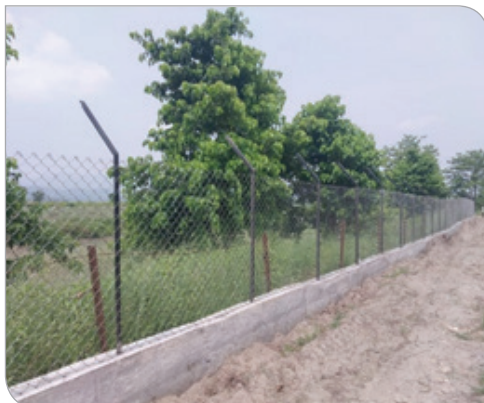
पि.सि. सि. सहितको मेषजाली निर्माण, चितवन रा.नि.
