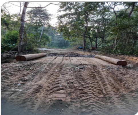
वन पथ निर्माण, चितवन रा.नि.
