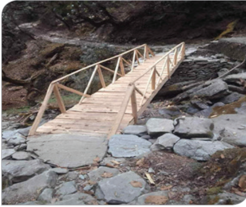
काठे पुल निर्माण, लाङटाङ रा.नि.
