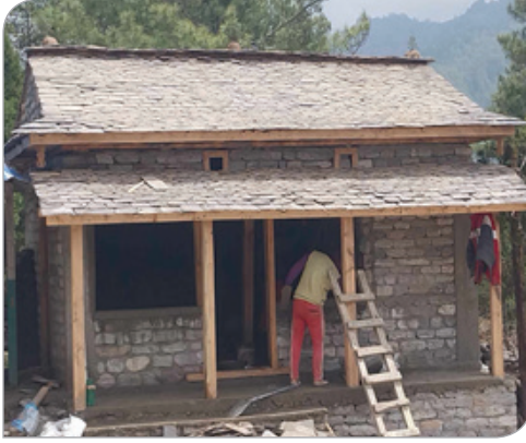
होमस्टे प्रवर्धनका लागि चिनो पसल निर्माण, ढोरपाटन व.आ.
