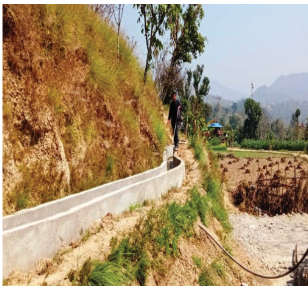
सिंचाई कुलो निर्माण, तीनपाटन वडा नं.-४, बेलटार, सिन्धुली
