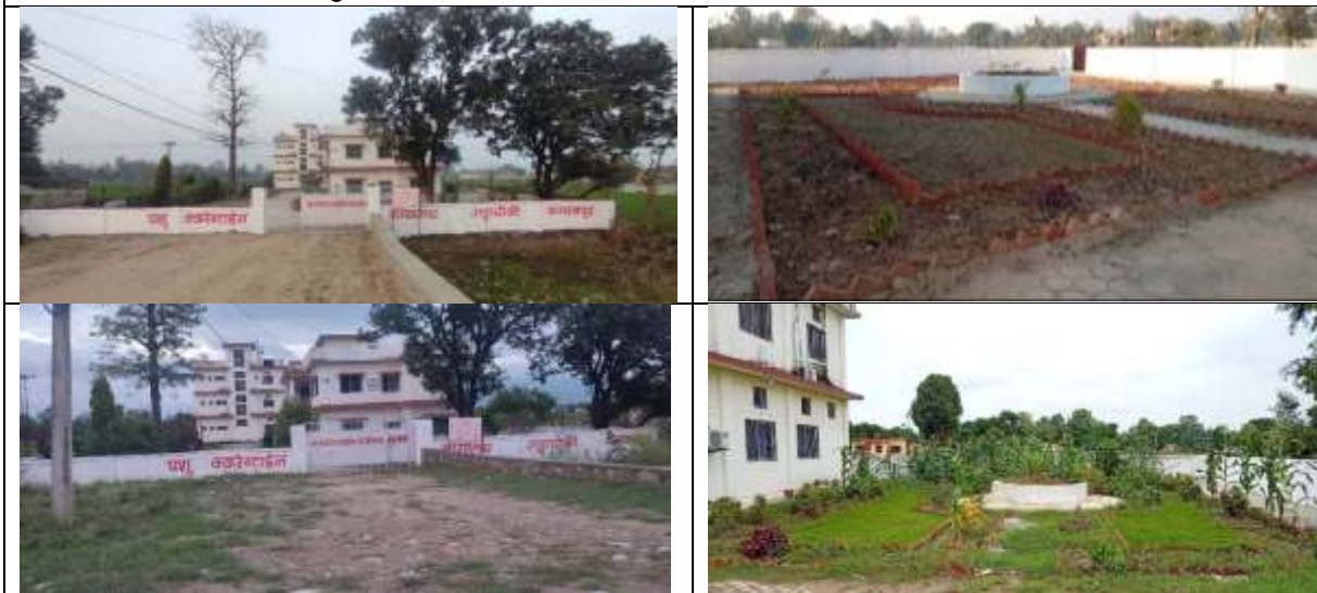
कार्यालयमा ढल व्यवस्थापन, बगैचा निर्माण र ढलान बाटो (परिसर भित्र) निर्माण कार्य
