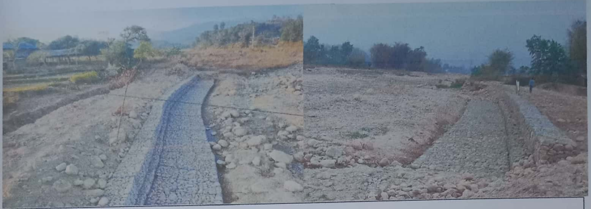
छाउरी खोला तटबन्ध निर्माण, उदयपुर
