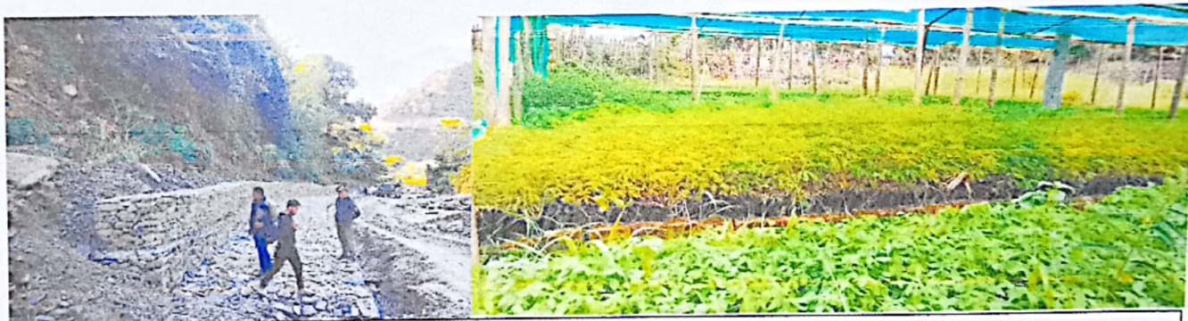
भालुखोला खोला बस्ती संरक्षणको लागि ग्याबियन वाल निर्माण, ओखलढुंगा तथा बिरुवा उत्पादन, उदयपुर
