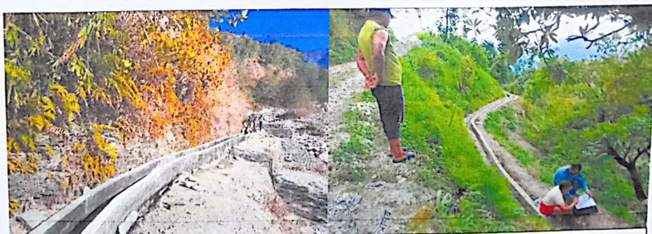
आर.सि.सि. कुलो निर्माण, ओखलढुंगा तथा आर.सि.सि. कुलो निर्माण, सोलुखुम्बु
