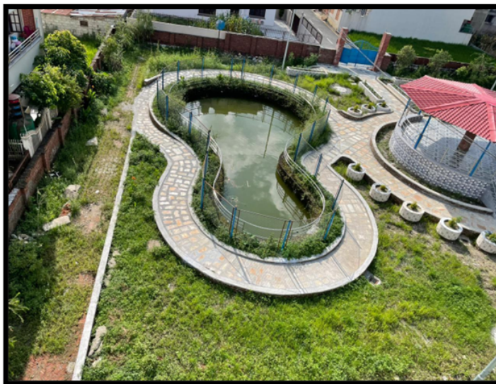
गाखु पार्क निर्माण, मध्यपुर थिमि नपा ८ नं वडा, भक्तपुर
