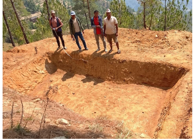
खानेपानी पुनर्भरण योजना अन्तर्गत वन क्षेत्रमा निर्माणाधिन पानी पोखरी
