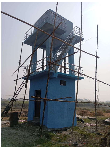
पम्प घर निर्माण हुँदै, सुनबर्सी-६, मोरङ
