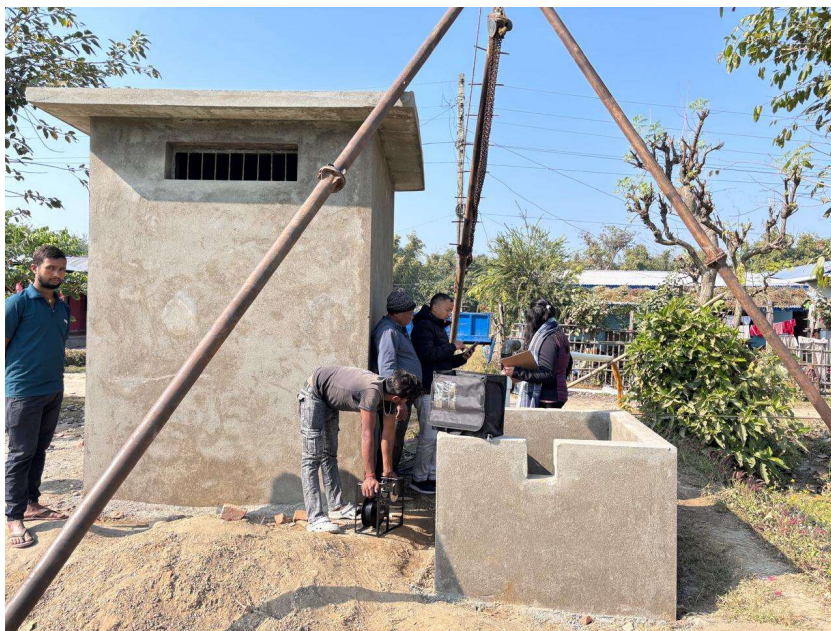
पम्पघर निर्माण तथा सब-मर्सिबल पम्प जडान हुँदै, त्रियुगा-५, राईटोल, उदयपुर
