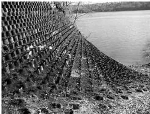
Fig: Toe Wall
