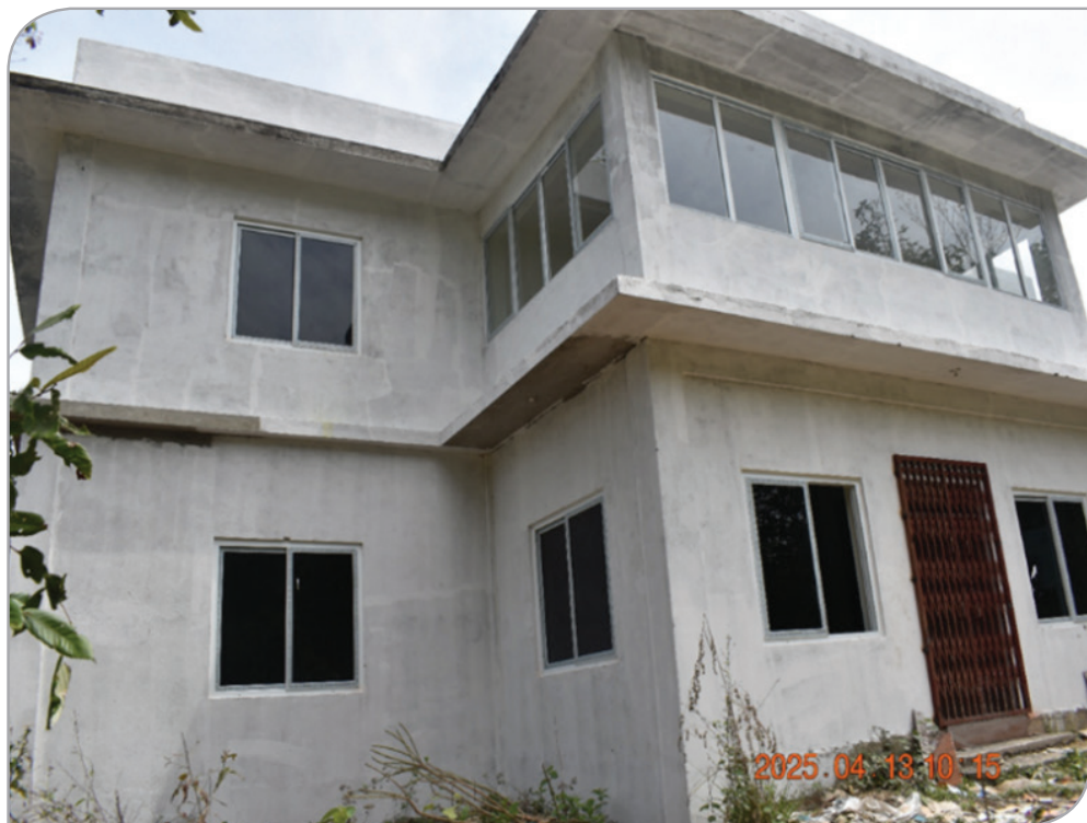
अधुरो भवन निर्माण, भानुभक्त प्राणी उद्यान, तनहुँ
