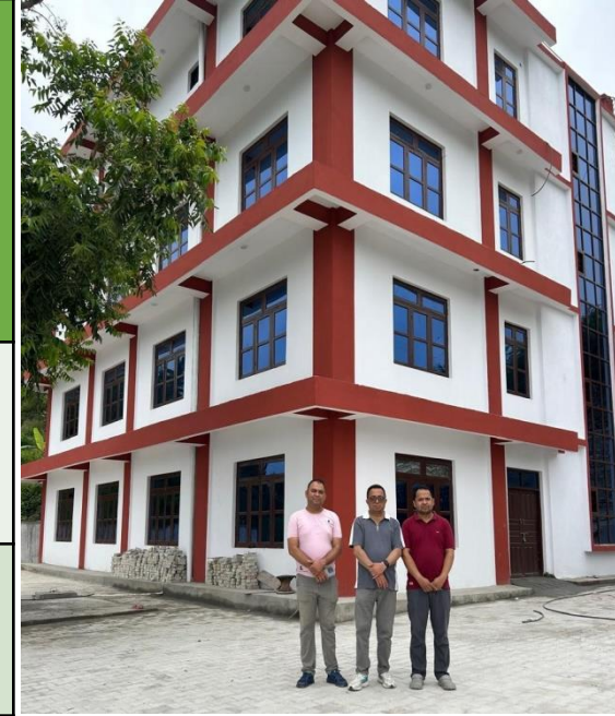
निर्मित कार्यालय भवन, बृ.ज.व्य.केन्द्र, कर्णाली, जाजरकोट
