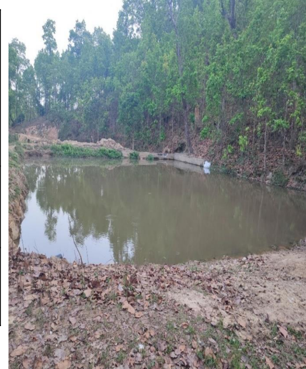
गैडाकोट-११ मा वाटर हार्भेस्टिङ प्रणालीको संरचना निर्माण
