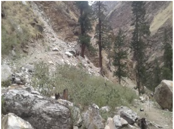
सडक खण्डमा रहेको बाटोको अवस्था(६१+२५०)
