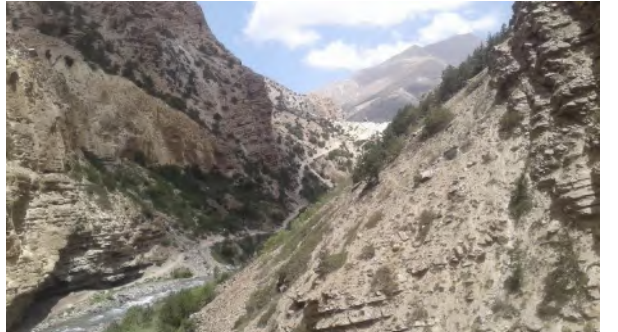
सडक खण्डमा रहेको बाटोको अवस्था(५७+८००)
