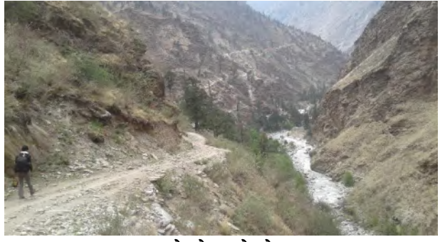
सडक खण्डमा रहेको बाटोको अवस्था(३४+४५०)
