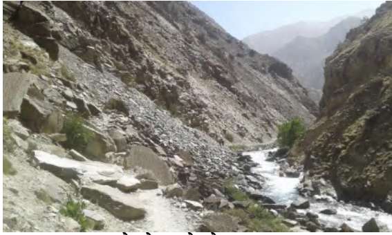
सडक खण्डमा रहेको बाटोको अवस्था(२९+२८०)
