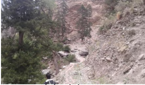
सडक खण्डमा रहेको बाटोको अवस्था(२९+२००)
