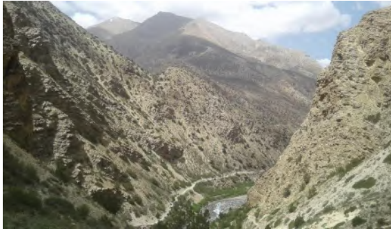
सडक खण्डमा रहेको बाटोको अवस्था(५३+९५०)
