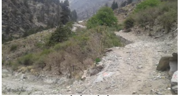
सडक खण्डमा रहेको बाटोको अवस्था(४५+६००)
