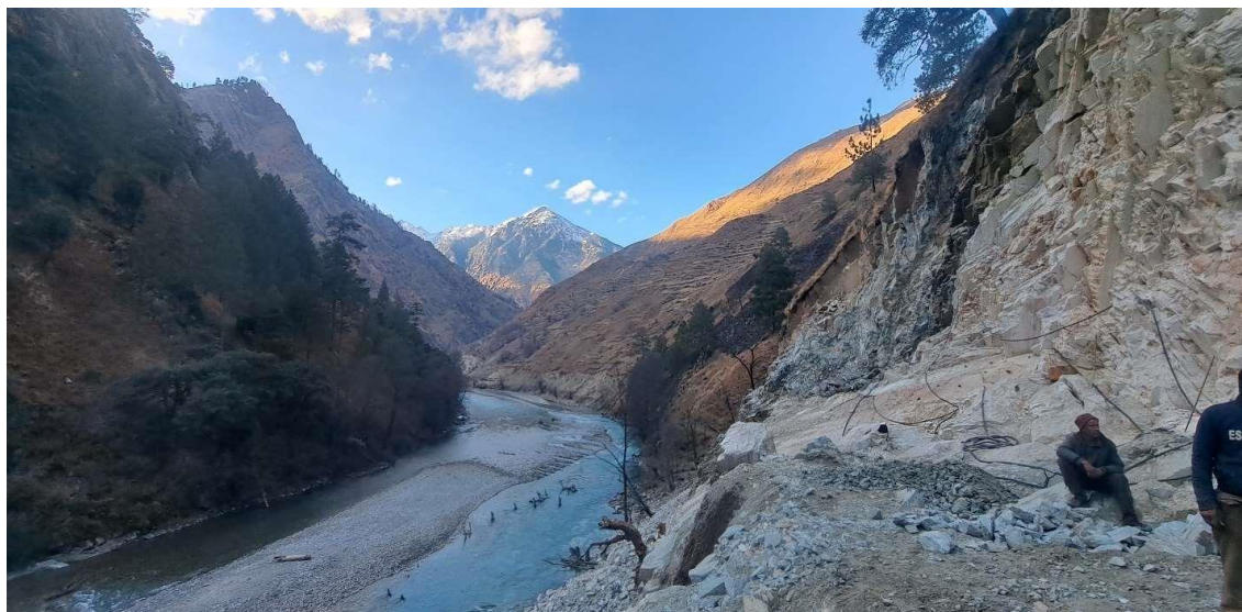
प्लेट ५-२: हेडरेस टनेल अलाइन्मेन्टमा अवलोकन गरिएको strong and jointed quartzite bands
