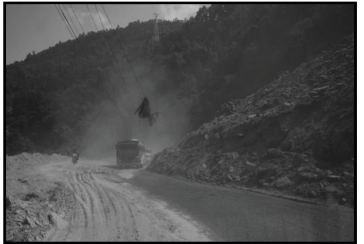
नागढुंगा-मुग्लिन सडकखण्डमा पहिरोले बिगारेको सडक । तस्बिर : अंगद ढकाल/कान्तिपुर
