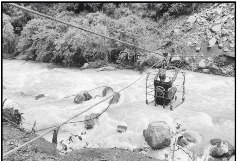
घुन्सा खोला रहेको भोलुङ्गे पुल पहिरोले भत्काएपछि सञ्चालन भएको तुइन ।
