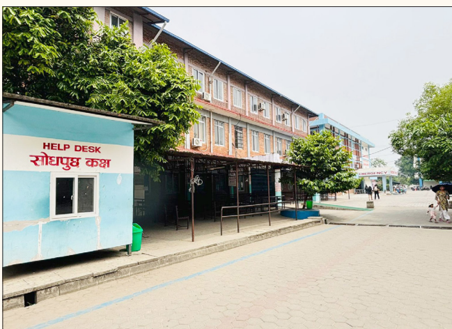
अस्पतालको सोधपुछ कक्षबाट देखिने ओ.पि.डि. ब्लक तथा ट्रमा सेन्टर भवन
