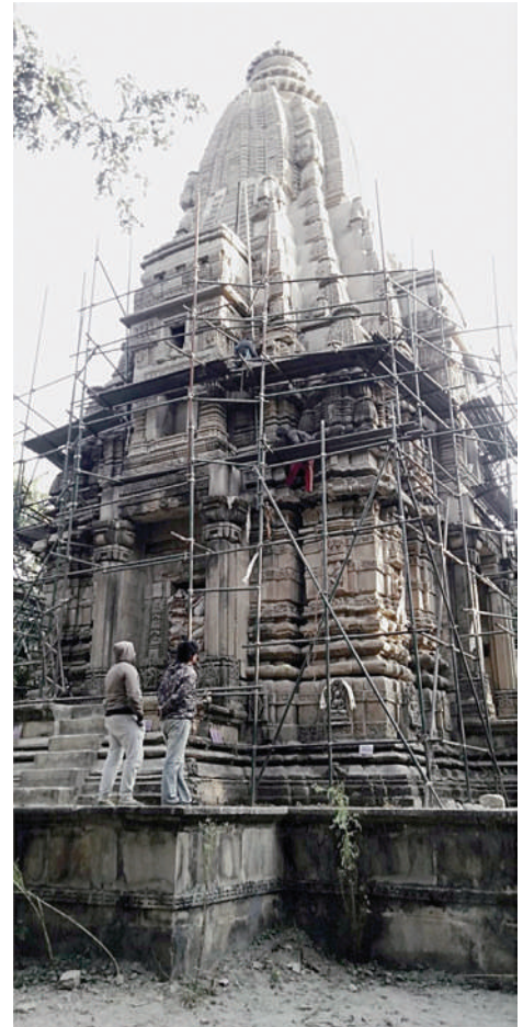
काक्रेबिहार निर्माण भइरहेको अवस्था
