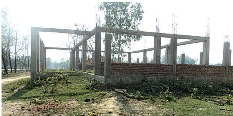
निर्माणाधीन थारू संग्रहालय
