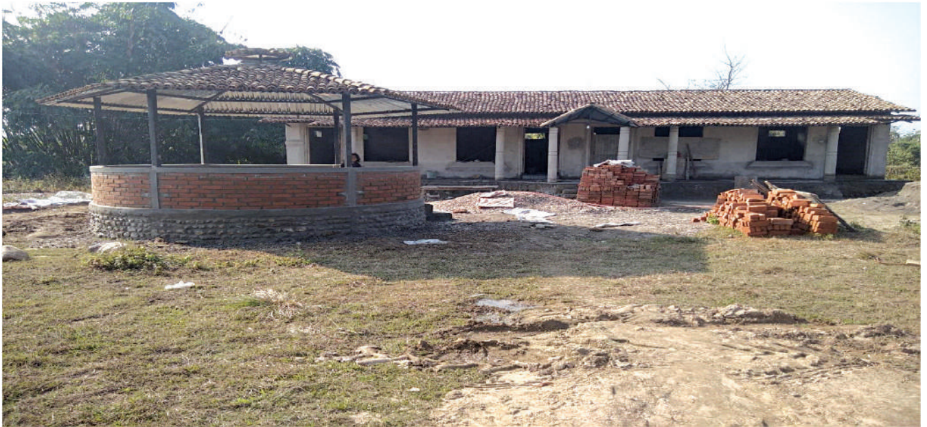
निर्माणाधीन थारु सामुदायिक भवन, साँड, नवलपरासी पूर्व
