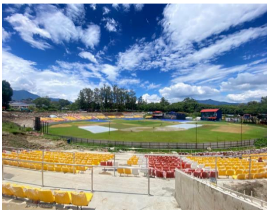
किर्तिपुर क्रिकेट मैदानमा अन्तराष्ट्रिय मापदण्ड अनुरूप प्यारापेट निर्माण तथा फ्लडलाईट जडान कार्य
