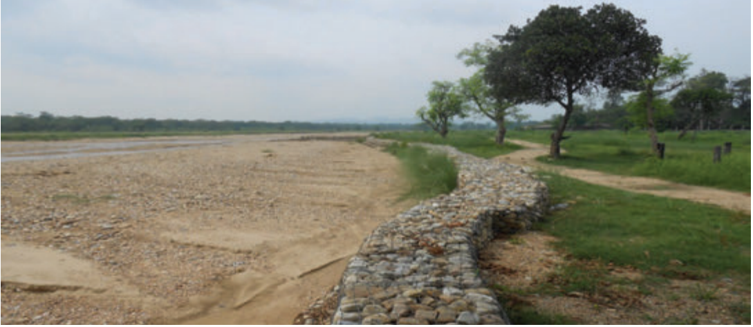
चितवन रा.नि.कार्यालयबाट निर्माण भएको तटबन्ध
