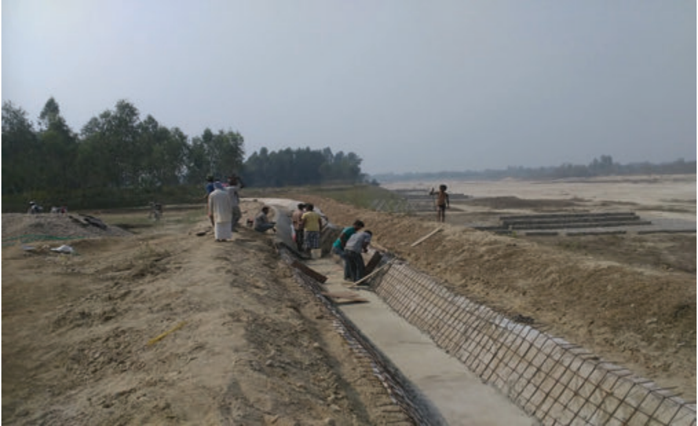
स्लोप स्टेबलाईजेसन र आर.सी.सी. क्वाच ड्रेन निर्माण
