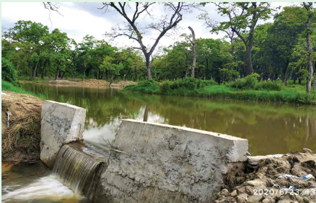
भूमिगत जल पुनर्भरण पोखरी निर्माण टिकौलीपोखरी रत्ननगर १२, चितवन
