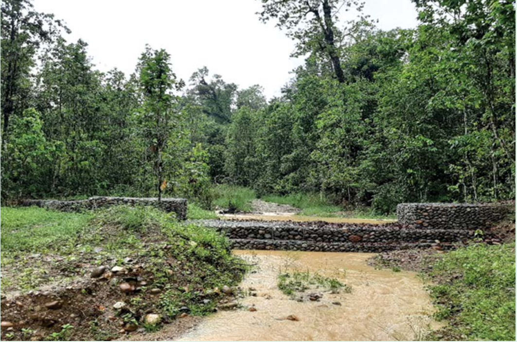
गल्छी पहिरो खहरे रोकथाम बागमती- ४ नदी प्रणाली, सिन्धुली
