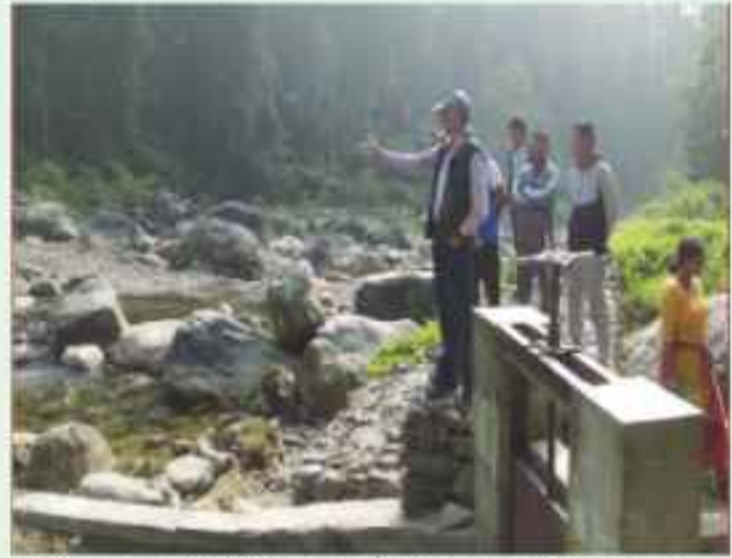
सिंचाई कूलो निर्माण: कार्य गैडाकोट न.पा-१२, नवलपुर
