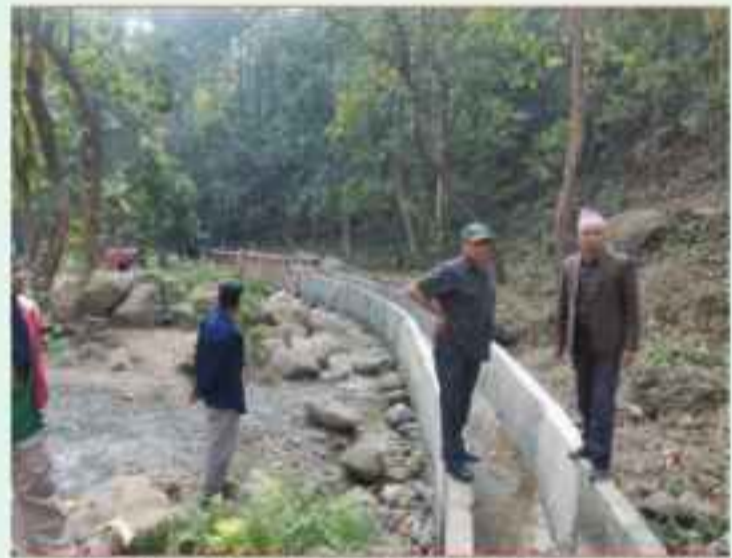
सिंचाई कूलो निर्माण: गैडाकोट न.पा-१२, नवलपुर
