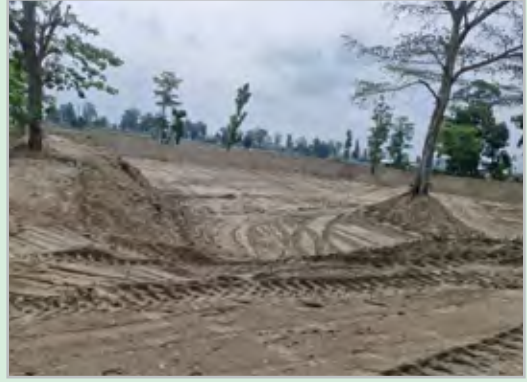
संरक्षण पोखरी निर्माण, धनगढी ७, सिद्धबाबा सा.व.उ.स.
