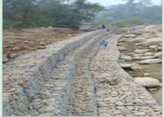
नदी तथा खोला किनार संरक्षण वाणगंगा ०९ भोर्लाबास कोइला खोला
