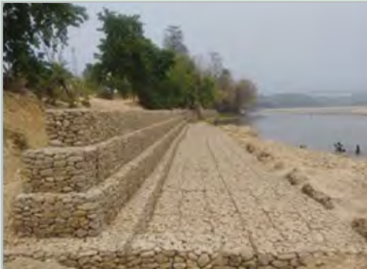
नदी तथा खोला किनारा स्थिरिकरण/ व्यवस्थापन, राप्ती सोनारी १, फुर्केसल्ली बाँके
