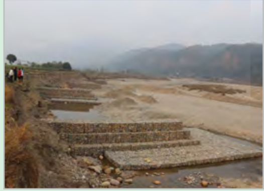
नदी तथा खोला किनारा स्थिरिकरण, मध्यविन्दु न.पा. १०, नवलपरासी (ब.सु.पू.)
