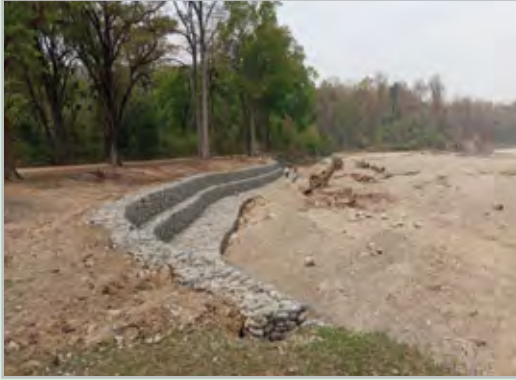
नदी तथा खोला किनारा स्थिरिकरण/ व्यवस्थापन, घोडाघोडी न.पा. १०, बुलबुले कैलाली
