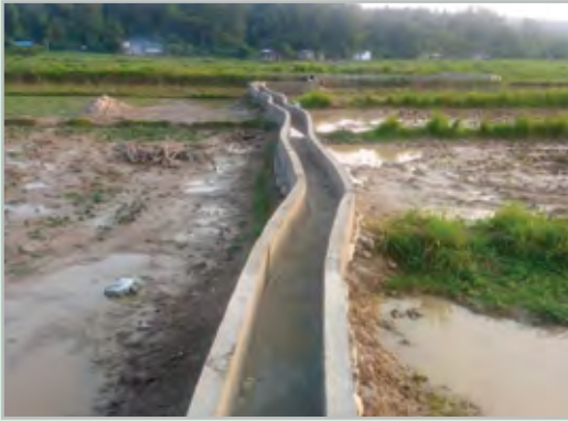
सिंचाई कुलो निर्माण/ मर्मत, राप्ती सोनारी गा.पा. १ बाँके
