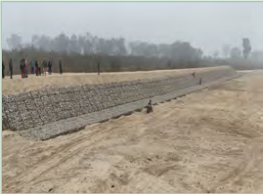
नदी तथा खोला किनारा स्थिरिकरण, ठोरी ५, ओरिया खोला, पर्सा
