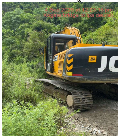
भीमफेदी कोगटे सिस्नेरी सडक (इपा देउराली खण्ड) मा हाल ४ लोडर तयारी अवस्थामा, २ Excavator र १ tractor प्रयोग गरि मर्मत/सन्चालन कार्य गर्दै
