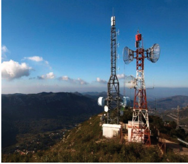
चित्र 13.1 दूरसञ्चारको सङ्केत रिसिभर र ट्रान्समिटर
