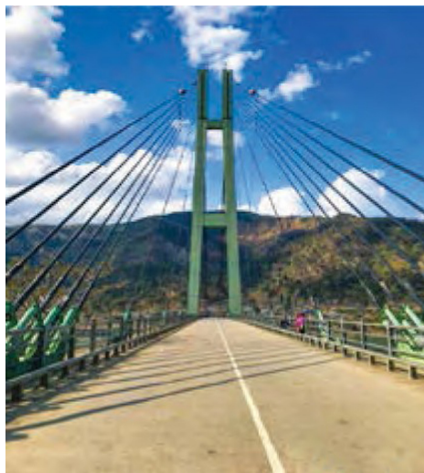
चित्र 7.26 एक खम्बामा अडिएर रडहरूले थामिएको कर्णाली पुल
