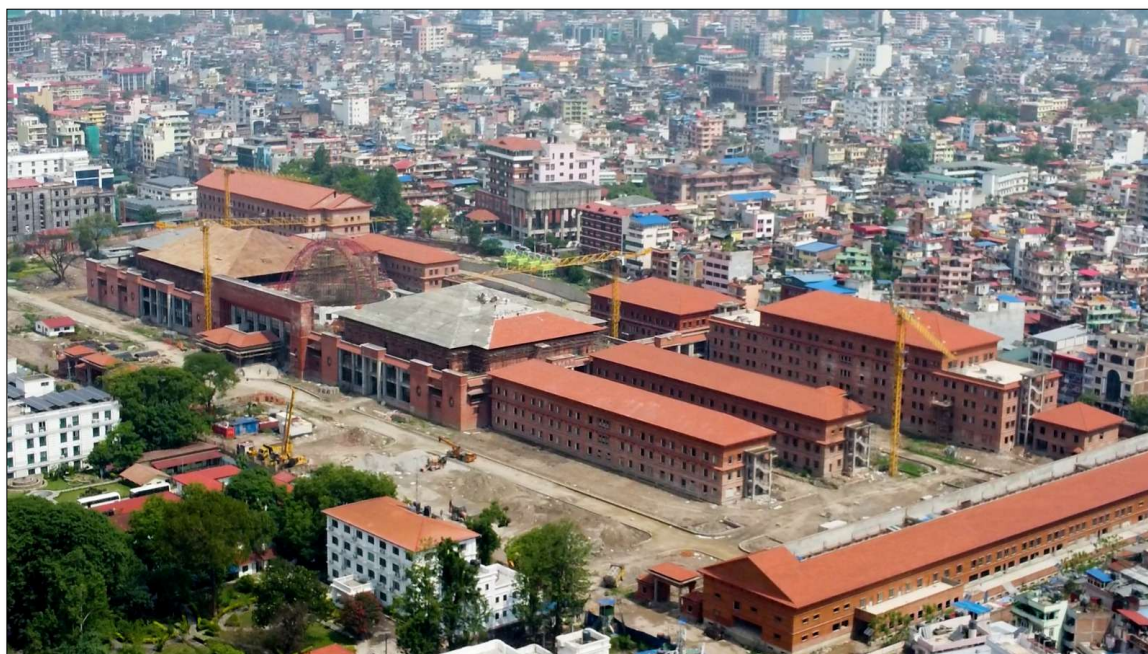
चित्र १४: सिंहदरबार परिसरमा निर्माणाधीन संघीय संसद भवन
