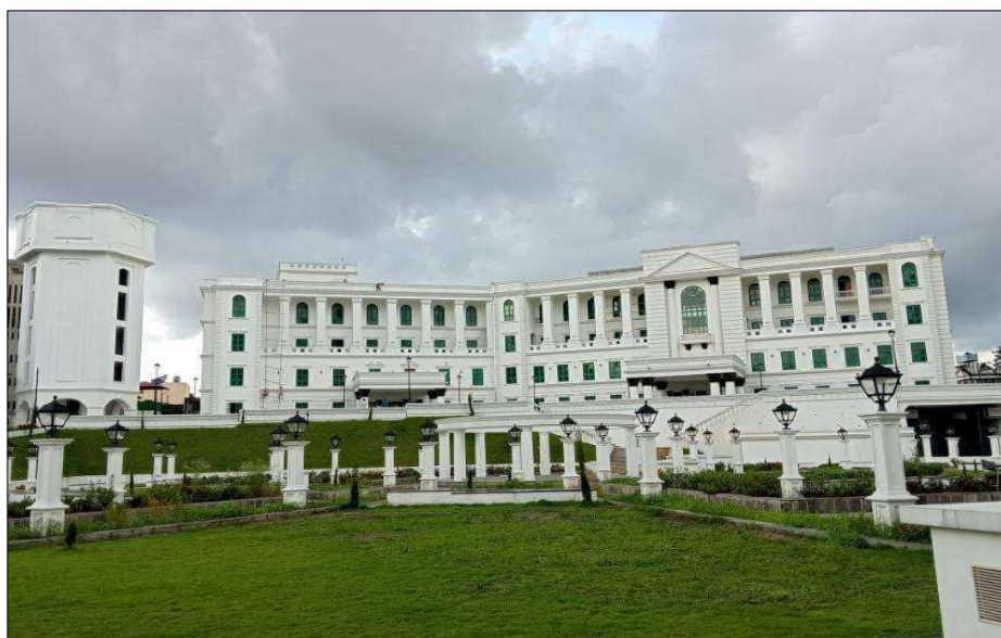
चित्र १: काठमाडौं जिल्ला थापाथलीमा निर्मित राष्ट्र बैंकको केन्द्रीय कार्यालय भवन
